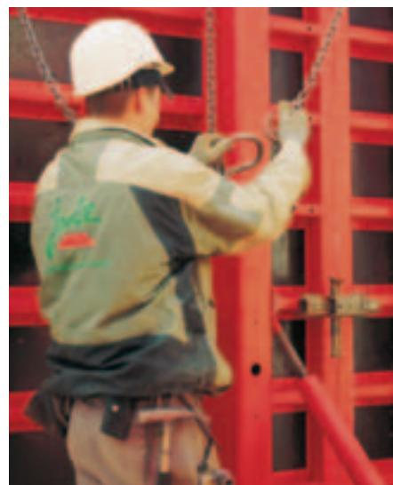
Trappestige TRH 90 muliggjør sikker montering av den øverste BFD systemlåsen på TRIO boligform 360 uten bruk av løs stige.
