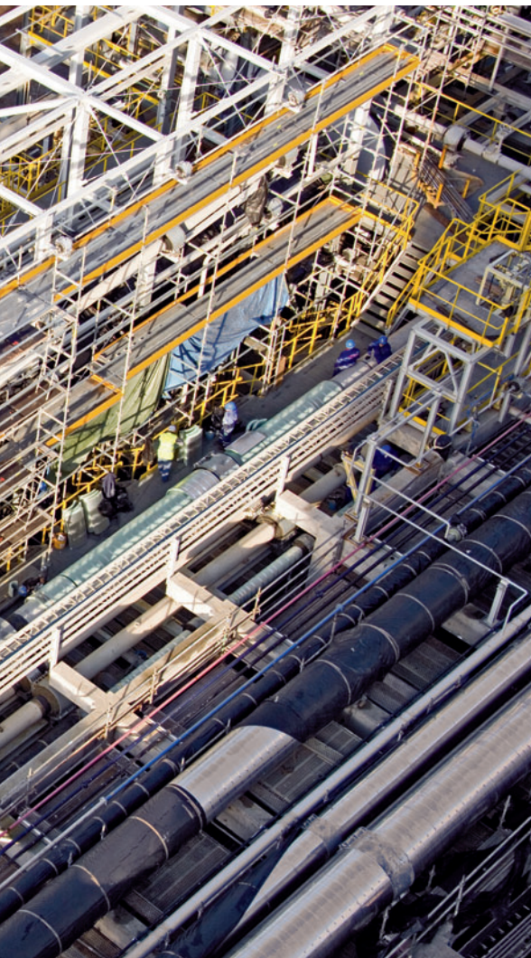
Arbeitsplasser for installerings- og vedlikeholdsarbeider monteres hurtig med PERI UP. Stålplasser monteres kun der hvor de er nødvendige.
