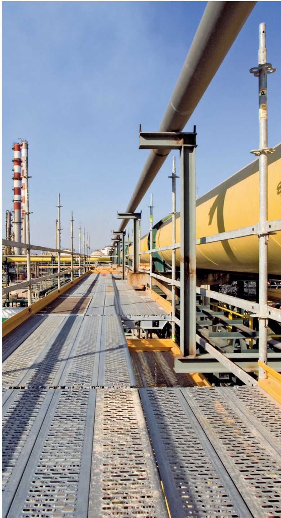
Lette horisontalrigler som rekkverk. For plattformene brukes alt etter belastning forsterkede eller uforsterkede rigler.
