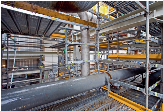
Rekkverk og sparkebord kan tilpasses de lokale forhold.
