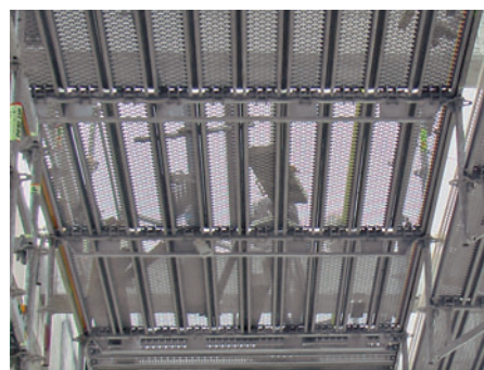
En plattform som er helt tildekket med PERI UP systemplank.
