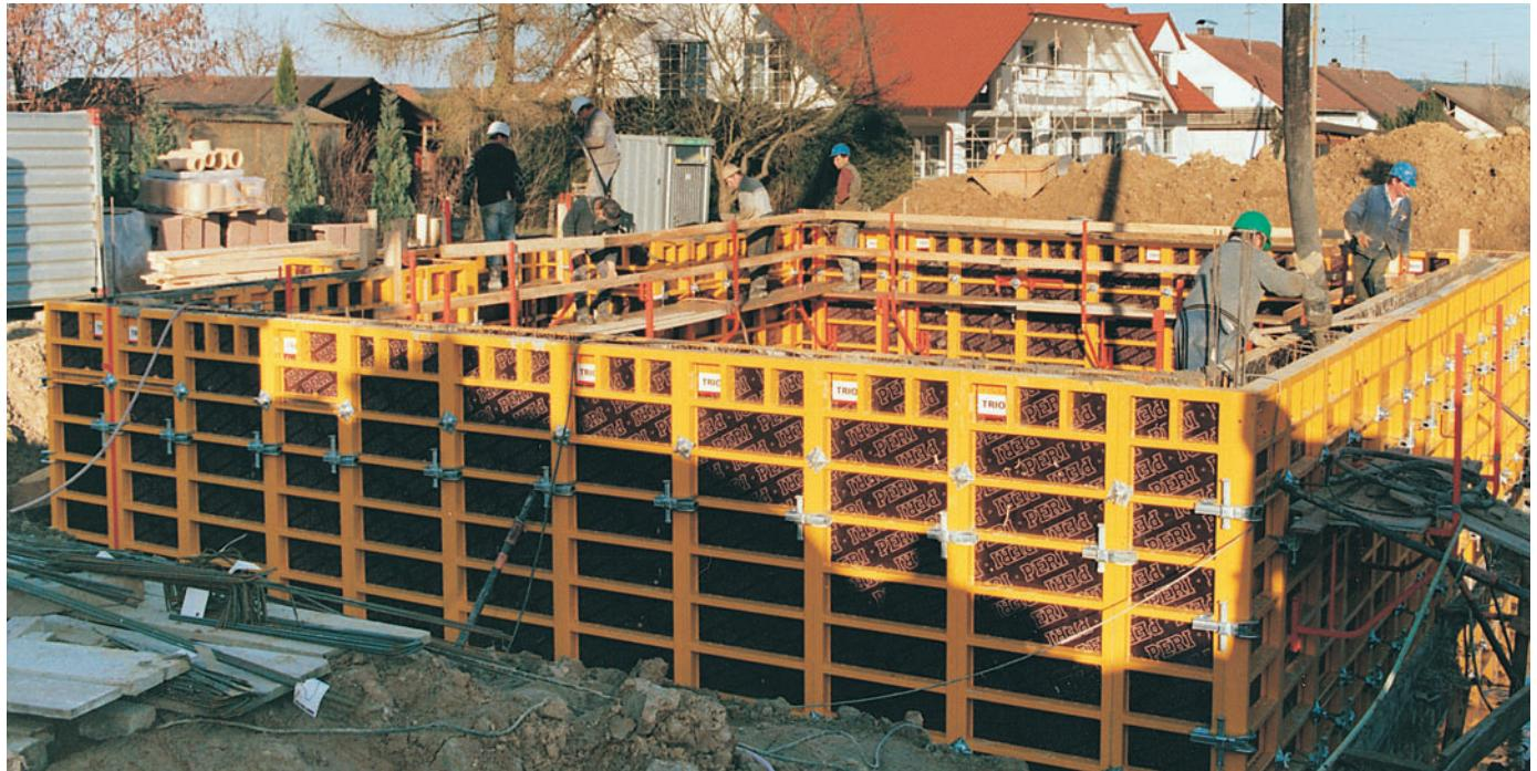
**TRIO-L (alu)** elementer har samme dimensjoner som TRIO stål elementer, slik at de to systemene kan kombineres.
