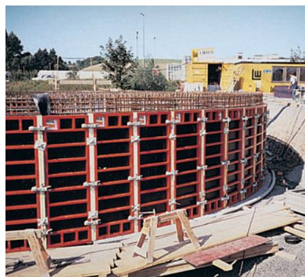
Standardelementer for runde konstruksjoner
