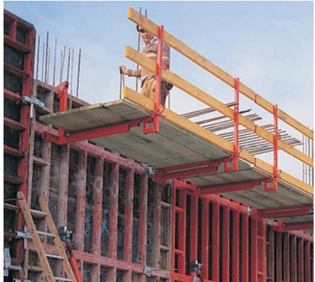
I stedet for den vanlige arbeidskrevende prosedyren (montere konsoler, legge gulv bord og montere rekksverk), har man med en TRIO støpeplattform en forskaling som er klar for støping med en gang:
