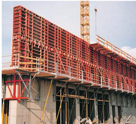
Plattformen forankres med strekkbånd i foregående staghull for å sikre plattformen mot vindkrefter, opp til 5,40 m i dette eksempelet.
