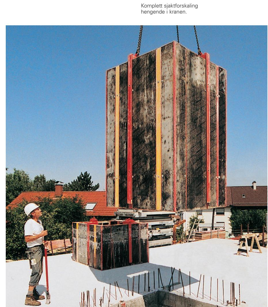
For å lette avforskaling (løsne forskaling fra betong) brekker man oppover med et spett eller brekkjern. Ved oppstilling av forskaling gjør man motsatt, brekker nedover.
