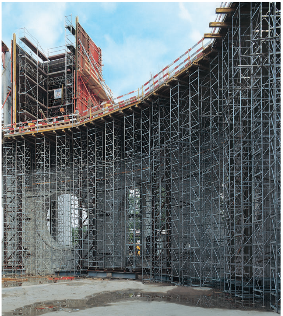
MULTIPROP 350 med MULTIFLEX dekkforsking.
