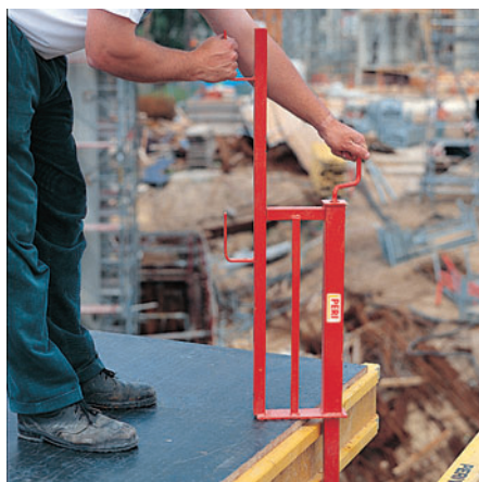
PERI rekkverksholderen skrues bare fast.
