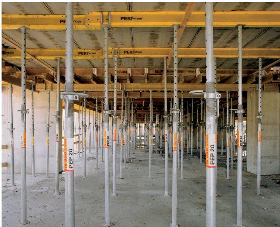
PERI drager VT 20 og PEP dekkstøtter til understøttelse av plattendekker
