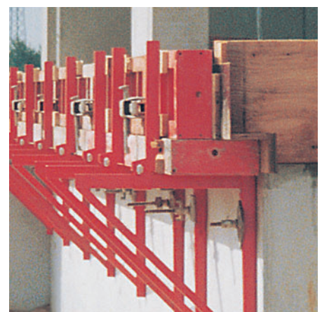
Liten utkraging med forskalingskonsoll-2.
