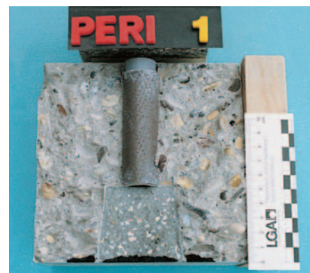
En tett staggjennomføring er det mest økonomiske!
