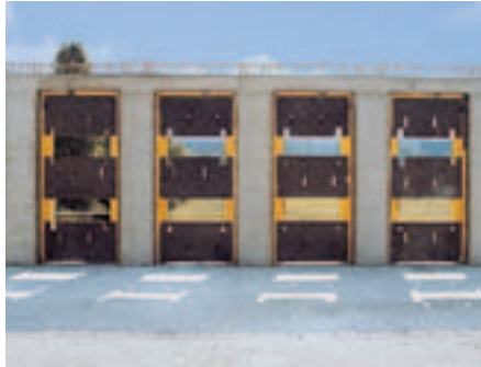
Beste Ergebnisse nach dem Entfernen der Schalelemente – sauberes Betonbild und hohe Maßhaltigkeit.
